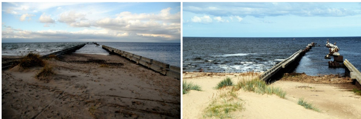
Joonis 4.1.2.1. Kiiresti lagunev muul Narva-Jõesuus (Foto S. Suuroja. Vasakul 2008.a; paremal 2010.a).
