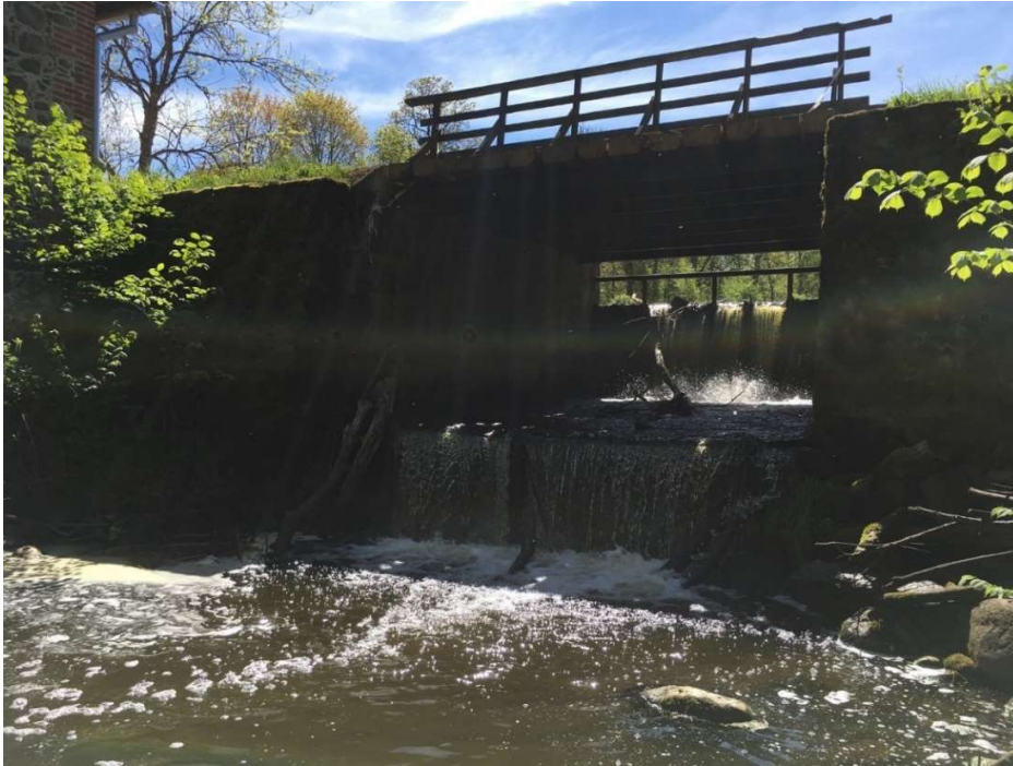
Foto 36. Umbes kolme meetri kõrgune Lahmuse järve pais (86,3 km merest) on Lõhavere oja kalastikule aastaringiselt (veeseisust olenemata) ületamatuks rändetõkkeks (17.05.2019 M. Kesler).
