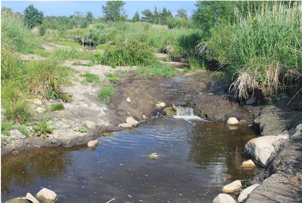
Foto 31. Savist aste endisest Päriveri paisust ca 450 m ülesvoolu, 0,8 km suudmest. Keskmisest madalama veeseisuga on saviaste kaladele rändetõkkeks (G. Lauringson, 16.06.2018).
