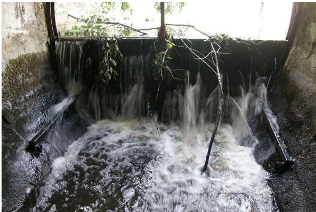
Foto 33. Kivi pais (h 0,84 m) asub Loodi oja alamjooksul 0,58 km suudmest. Pais on rajatud suure metallist teetruubi ette (R. Pihu; 25.07.12).
