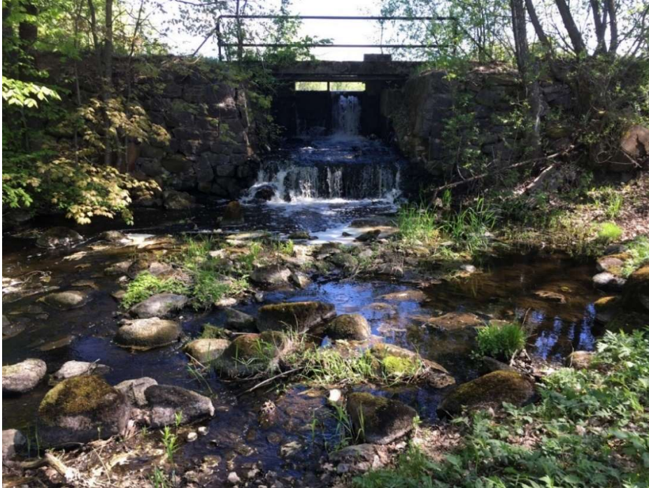
Foto 37. Lõhavere järve pais. Sarnaselt Lahmuse järve paisule on ka umbes 2,4 meetri kõrgune Lõhavere järve pais kaladele aastaringsest ületamatu (17.05.2019 M. Kesler).
